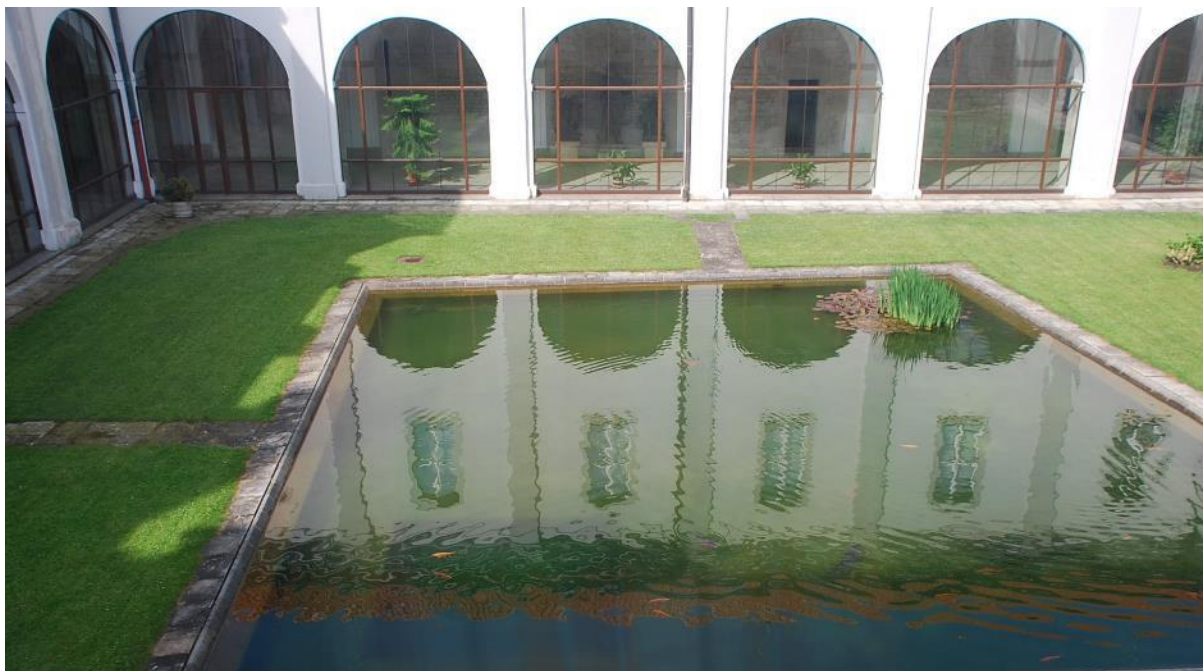
Obrázek 2 – Ambit Strahovského kláštera v Praze. Románská piscina v rajsském dvoře s lichoběžníkovým půdorysem je široká 13 m a dlouhá 11 m při hloubce zapuštění 0,85 m pod úroveň terénu. Značná kubatura vody v piscině byla doplňována ještě jedním přívodem vody, který byl veden kanálkem pod západním křídlem konventu. Na východním boku pisciny byl nalezen i přepad do odtokového kanálku. Poněvadž v piscině rajského dvora docházelo neustále k výměně vody, bylo tohoto příhodného stavu nepochybně na Strahově využito k chovu ryb [18; s. 181]. (Foto: autor, 2011)
