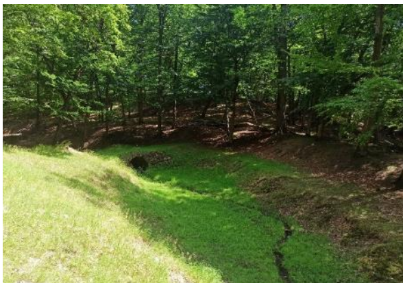
Obrázek 20 – Kamenný mostek oddělující retenční nádrže v Náměštské oboře, vytvářející otevřený prostor kolem nádrže a umožnění vstupu slunečních paprsků do území a přidání nového rozměru zdejší zalesněné krajiny. (autor: Tereza Jančová, 2022)
