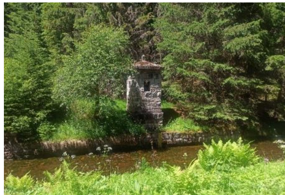
Obrázek 14 – Zpevněná část Vchynicko-tetovského kanálu a stavba pro vodočet, která byla další přidruženou částí plavebních kanálů jako jsou dále přepady, sáhové kameny pro délkové značení, skladiště, překladiště, vaziště nebo plavecké hospody a obydlí vorařů. (autor: Tereza Jančová, 2023)
