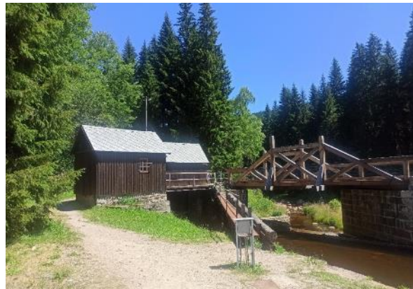
Obrázek 13 – Stavidlo a hradlový most zvaný Rechle, začátek Vchynicko-tetovského kanálu. Dalšími částmi byly vstupní portály, hradlové mosty (rechle), skluzy na dřevo, akvadukty, tunely, vzdouvací stavidla, vodní nádrže a rezervoáry (švele, klauzy) (autor: Tereza Švárová, 2023)
