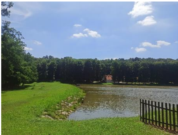
Obrázek 4 – Vodní plocha Střelnice v severovýchodní části Náměšťské obory, jejíž hráz tvoří osu severní brány obory. Vodní plocha má kromě užitkové (hospodářské) funkce zejména funkci estetickou, vytváří otevřený prostor jinak zalesněné plochy obory, zrcadlí budovu původní střelnice v severní části a hospodářské budovy (stodoly) navazující na nedaleký areál hájovny (autor: Tereza Jančová, 2022)
